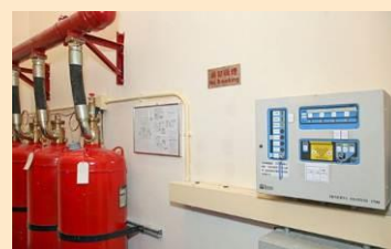
所有貯存庫均裝設 FM200 滅火系統
