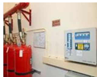
所有貯存庫裝設的 FM200 滅火系統
