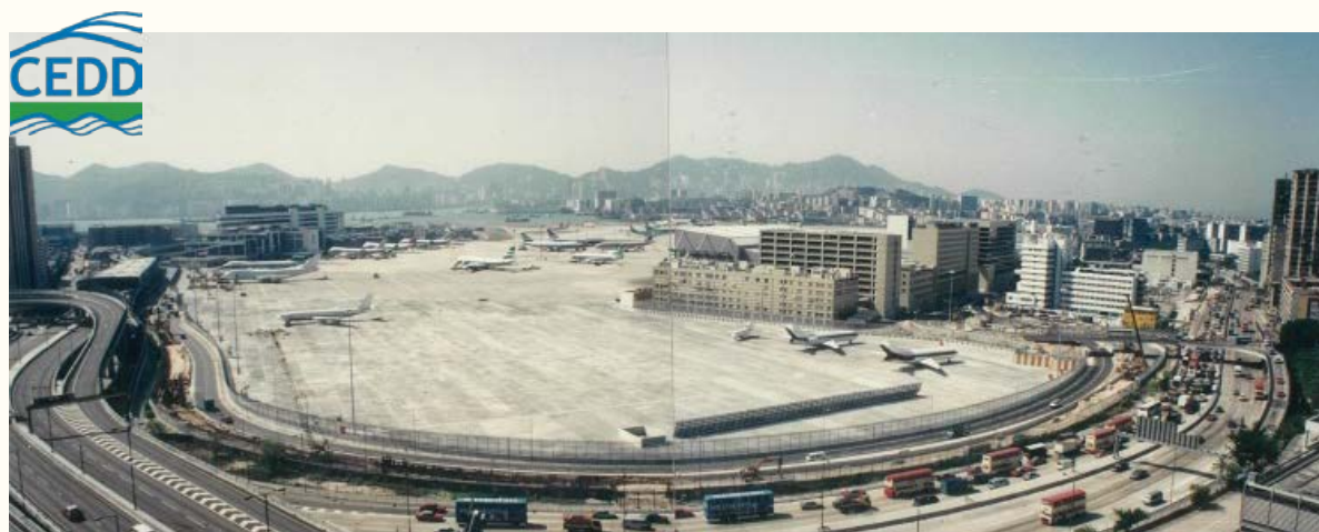
启德机场土力工程项目竣工后的停机坪全景 (1992年)
