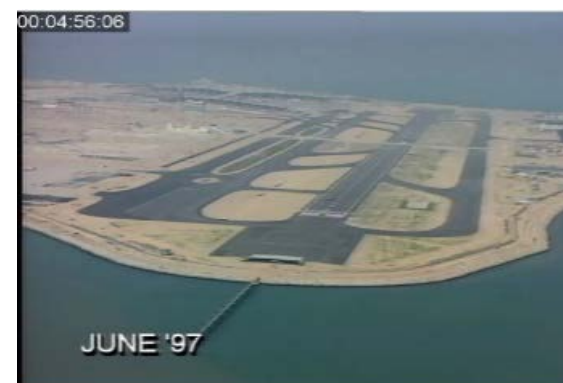
機場竣工前的最後階段 (參考編號：HKRS 2693-1-393)
