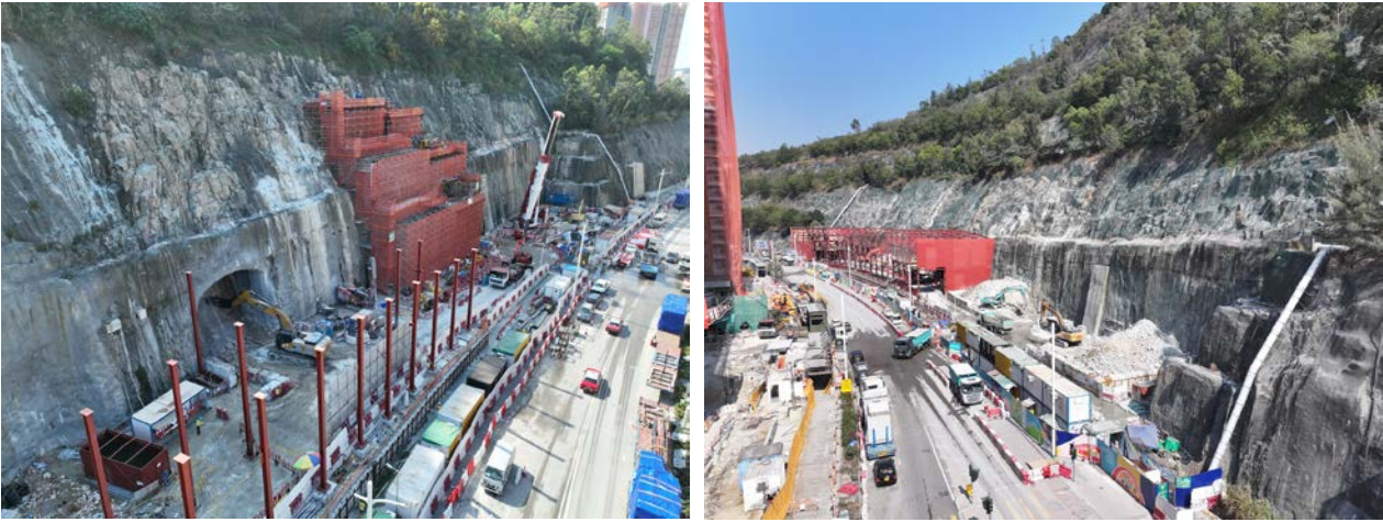
进行爆破工程以兴建历史档案中心
