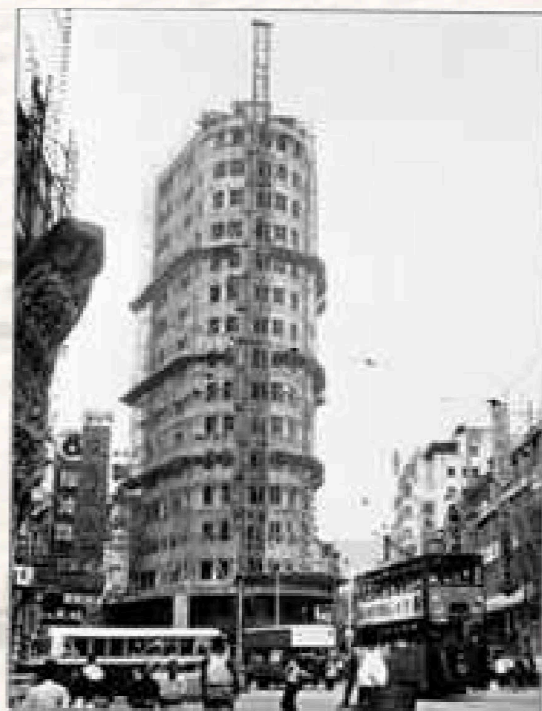
一幢位于庄士敦道及湾仔道交界兴建中的大厦（1963年）
