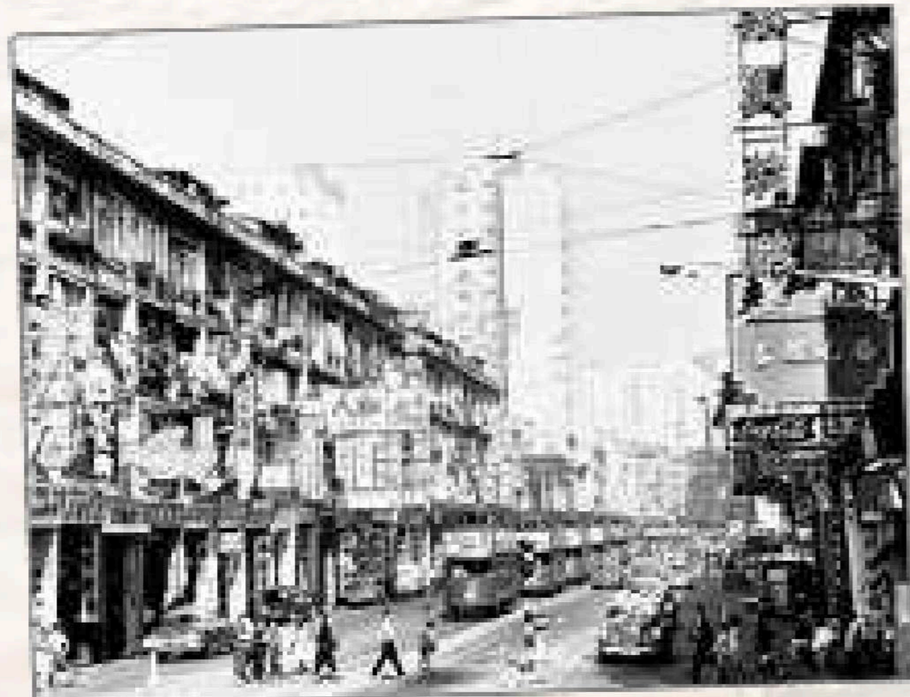
軒尼詩道近銅鑼灣段的住宅樓宇（1964年）
