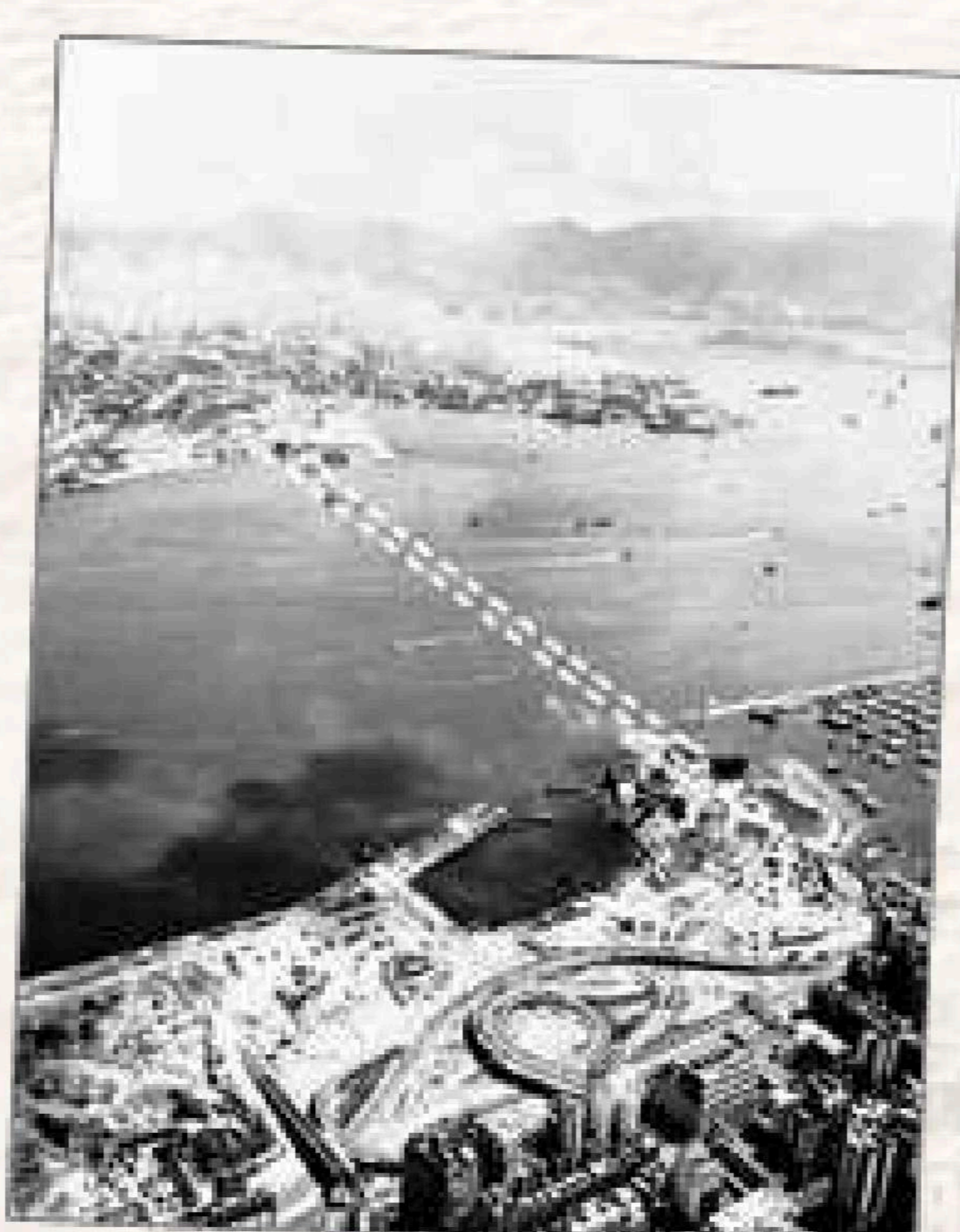
接近完成的海底隧道銅鑼灣段，虛線為隧道位置（1972年）
